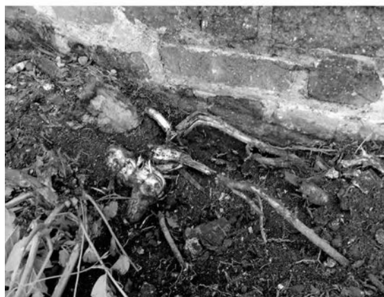
Fig. 14 | Imágenes del trabajo técnico de inspección de los bajantes pluviales (créditos: Alida Diez Sánchez, 2023). | Immagini dei lavori di ispezione dei pluviali (credits: Alida Diez Sánchez, 2023).
