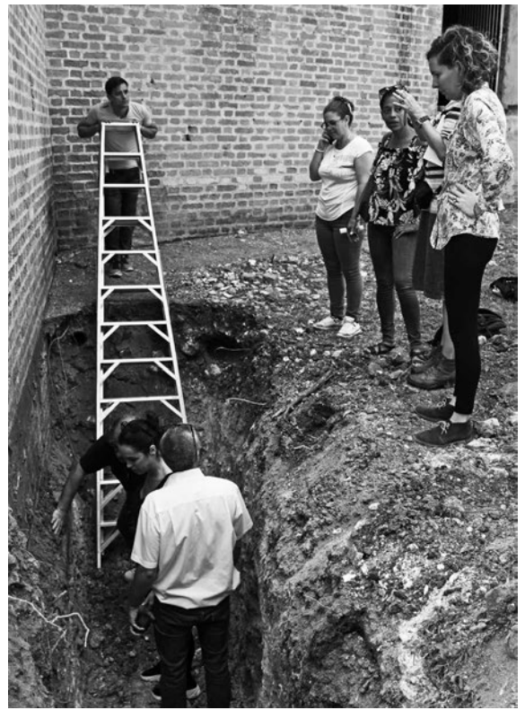
Fig. 2 | Excavación para documentar la tipología de las cimentaciones (créditos: Michele Paradiso). | Scavo per documentare la tipologia delle fondazioni (credits: Michele Paradiso).
