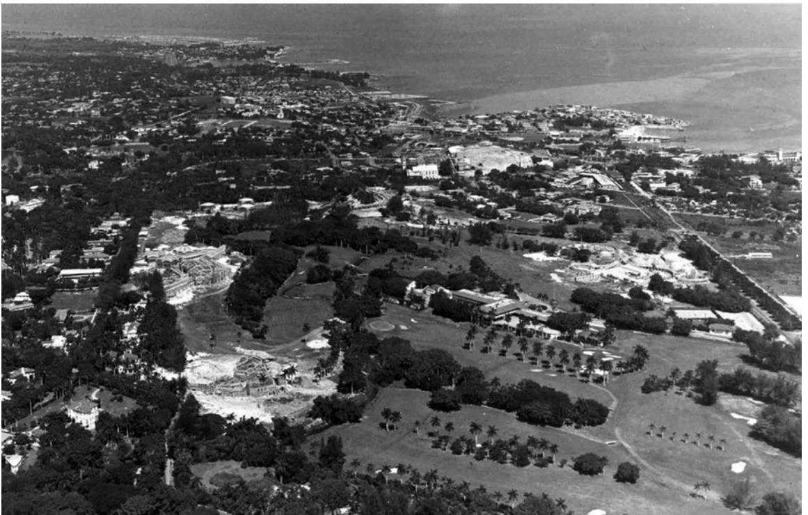
Fig. 6 | Vista aérea del Country Club y terrenos aledaños en 1963 con las Escuelas en construcción (fuente: archivo personal del autor). | Vista aerea del Country Club e dei terreni limitrofi nel 1963 con le Scuole in costruzione (fonte: archivo personale dell'autore).
