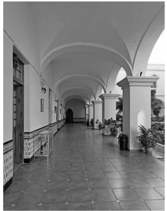
Fig. 7 | Bóvedas de arista del claustro del Convento de Santa Catalina de Siena en El Vedado, construidas por Rafael Guastavino hijo en 1914 (créditos: Vegas & Mileto). | Volte a crociera del chiostro del Convento de Santa Catalina de Siena nel El Vedado , costruito da Rafael Guastavino Jr. nel 1914 (credits: Vegas & Mileto).
