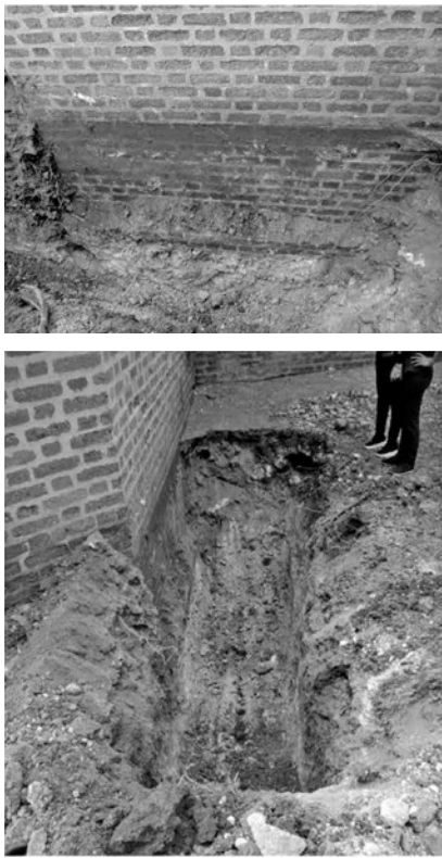
Fig. 13 | Imágenes de las calas de cimentación y soluciones de dren francés (créditos: Alida Diez Sánchez, 2021-2023). | Immagini dei saggi realizzati nelle fondazioni e delle soluzioni di scannafosso (credits: Alida Diez Sánchez, 2021-2023).
