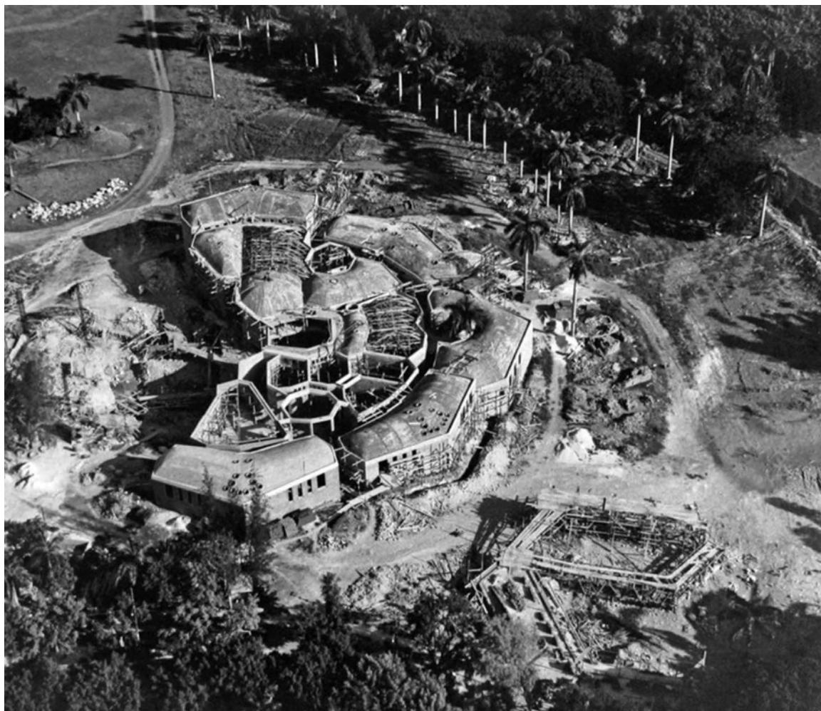
Fig. 15 | Vista aérea de la Escuela de Teatro en construcción (cortesía de Roberto Gottardi). | Vista aerea della Scuola di Teatro in costruzione (cortesía di Roberto Gottardi).
