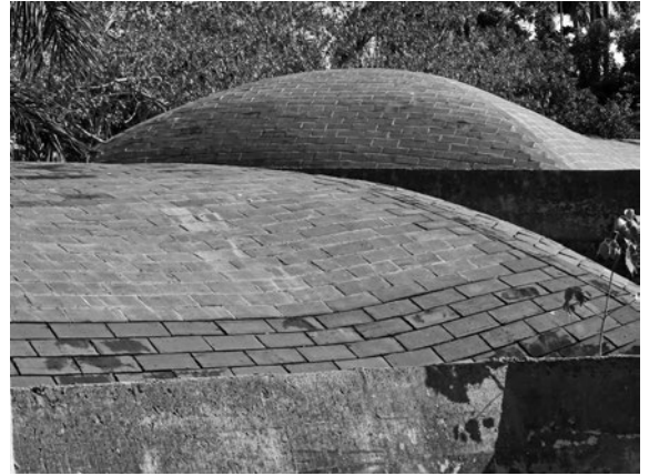
Fig. 20 | Una de las salas con bóveda atirantada salpicada de óculos de iluminación en la Escuela de Artes Escénicas de Roberto Gottardi (créditos: Vegas & Mileto). | Una delle sale con volta rinforzata con tiranti e punteggiata da oculi per l'illuminazione naturale della Escuela de Artes Escénicas di Roberto Gottardi (credits: Vegas & Mileto).
