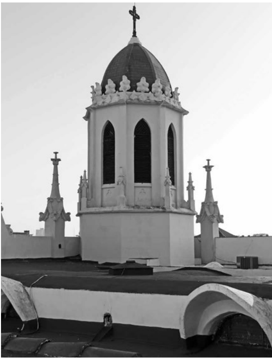
Fig. 6 | Cupulín gallonado sobre el campanario izquierdo de la iglesia y doble cubierta con ventilación de la cámara intermedia por los laterales bajo la terraza pisable en el Convento de Santa Catalina de Siena en El Vedado, supuestamente construida con bóvedas tabicadas por Rafael Guastavino hijo (créditos: Vegas & Mileto). | Cupoletta a padiglione del campanile sinistro della chiesa e doppia copertura con camera di ventilazione intermedia areata dalle aperture presenti dei lati al di sotto della terrazza calpestabile nel Convento de Santa Catalina de Siena nel El Vedado , presumibilmente costruito con volte in foglio da Rafael Guastavino Jr. (credits: Vegas & Mileto).
