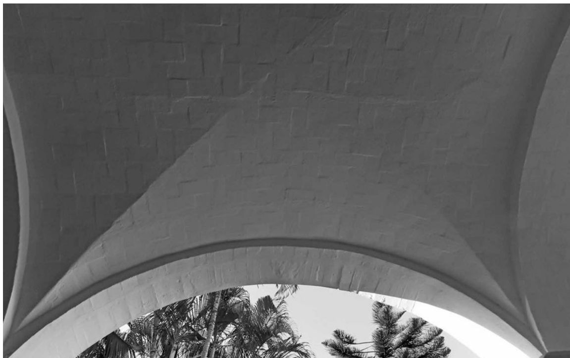
Fig. 8 | Detalle del aparejo en espina de pez de las bóvedas de arista del claustro del Convento de Santa Catalina de Siena en El Vedado, construidas por Rafael Guastavino hijo en 1914 (créditos: Vegas & Mileto). | Particolare dell'apparecchiatura a spina di pesce delle volte a crociera del Convento de Santa Catalina de Siena en El Vedado , costruito da Rafael Guastavino Jr. nel 1914 (credits: Vegas & Mileto).
