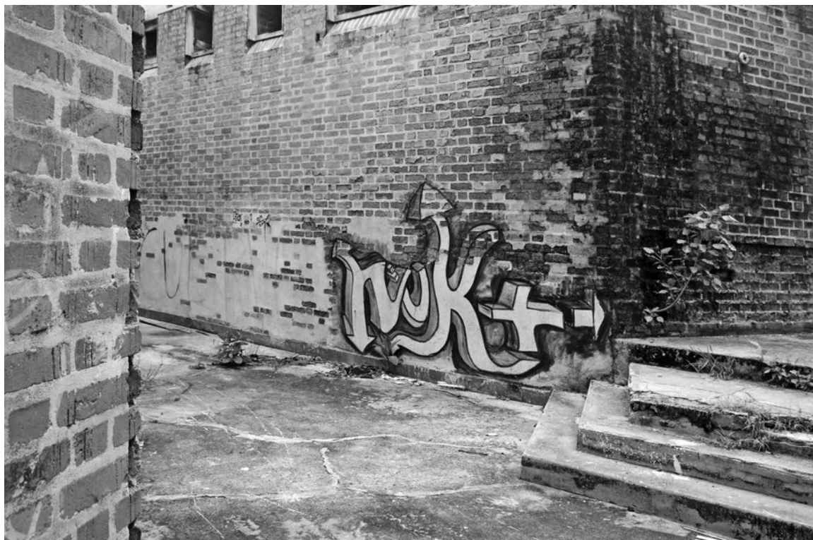
Fig. 20 | Degradación inducida por acción antrópica (créditos: Michele Paradiso). | Degrado indotto da azione antropica (credits: Michele Paradiso).
