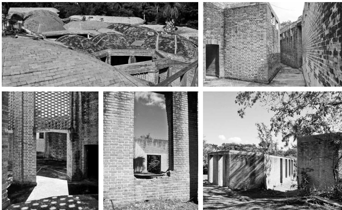
Fig. 2 | Imágenes del conjunto construidos, año 2019-2000 (créditos: Alida Diez Sánchez). | Immagini del complesso, 2019-2000 (credits: Alida Diez Sánchez).
