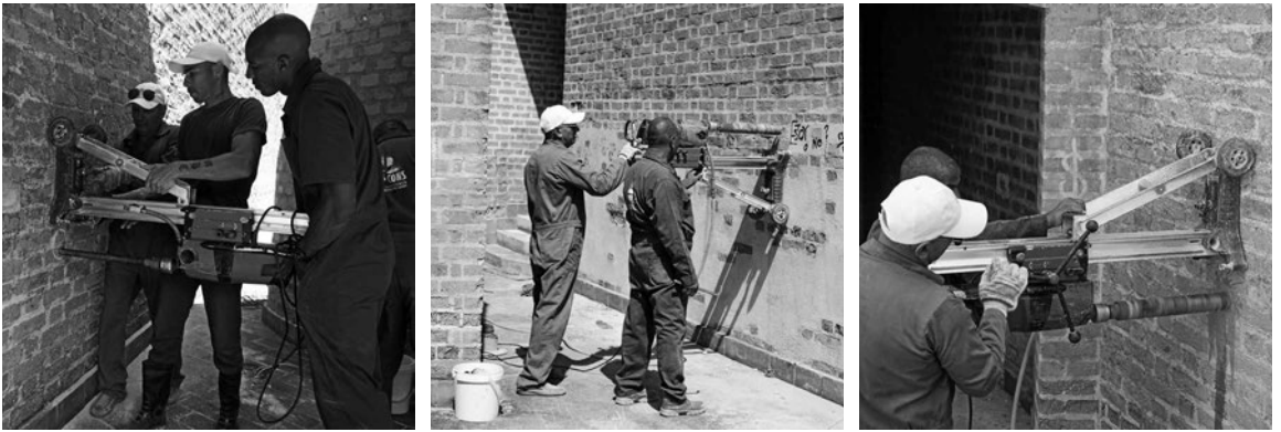
Fig. 23 | Ensayos en estructuras verticales (créditos: Sara Garuglieri). | Saggi nelle strutture verticali (credits: Sara Garuglieri).
