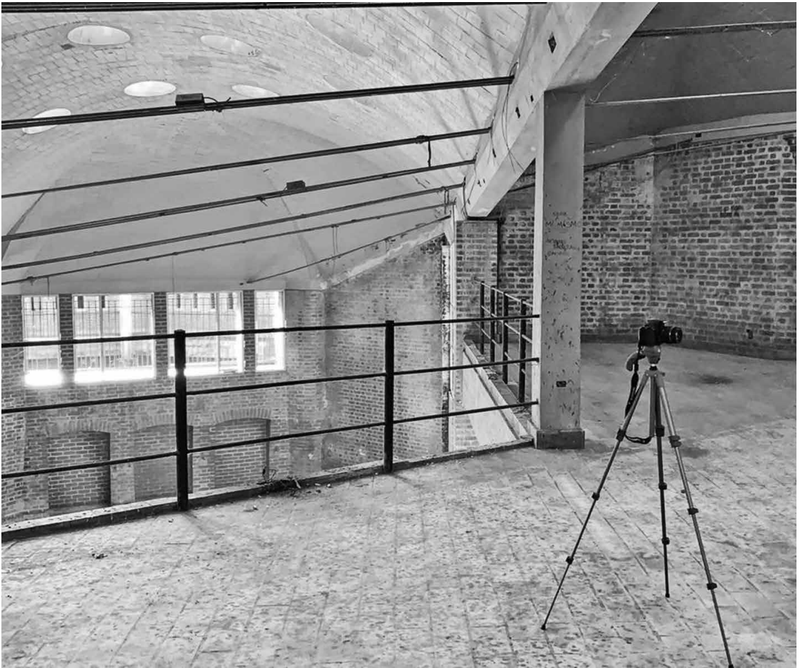
Fig. 33 | Toma fotográfica en el ballatoio del Bloque 11 (créditos: CHM_Lab). | Operazioni di presa fotografica sul ballatoio del blocco 11 (credits: CHM_Lab).
