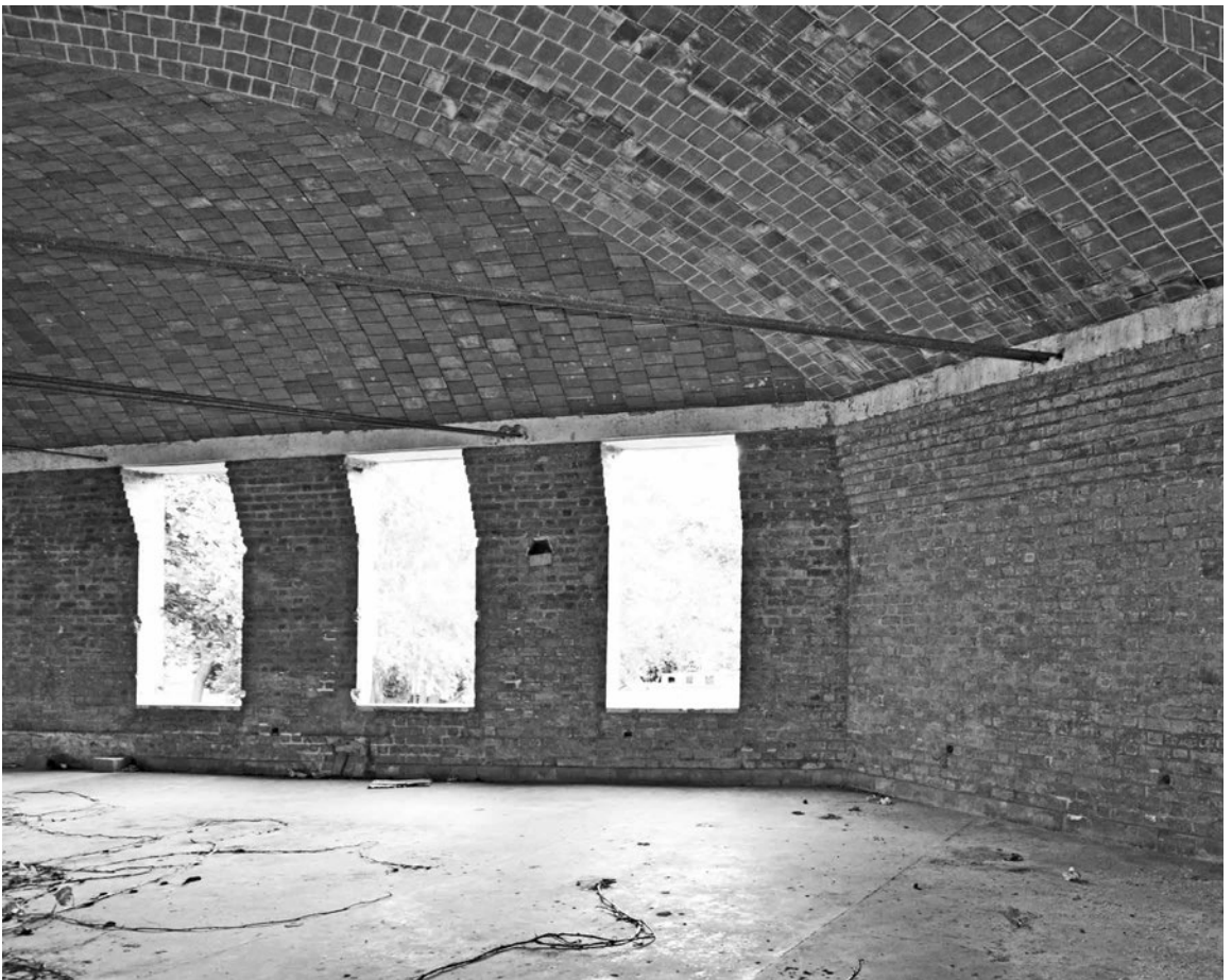
Fig. 31 | Tensores de acero con agarre mejorado (créditos: Michele Paradiso). | Tiranti in acciaio ad adherenza migliorata (credits: Michele Paradiso).
