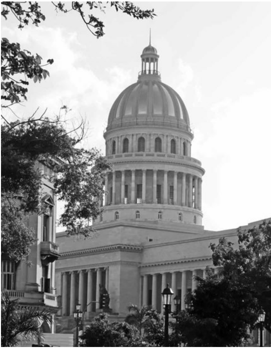
Fig. 3 | El Capitolio de La Habana (1929) posee algunas bóvedas tabicadas sobre el hemiciclo de la cámara de representantes (créditos: Vegas & Mileto). | Il Capitolio de La Habana (1929) presenta alcune volte in foglio che coprono l'emiclo della Cámara de representantes (credits: Vegas & Mileto).
