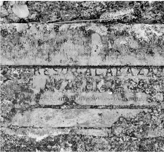
Fig. 13 | Izquierda: Escuela de Ballet, foto de la parte inferior de una rasilla con el nombre de los tejares de origen impreso. Derecha: Escuela de Teatro, detalle de un tabique con el sistema de identificación impreso en los ladrillos (fotografías de Christian Zecchin). | A sinistra: Scuola di Balletto, foto del fondo di una tavola con impresso il nome del tejares di provenienza. A destra: Scuola di Teatro, dettaglio di un setto murario con in evidenza il sistema di riconoscimento impresso sui mattoni (fotografie di Christian Zecchin).
