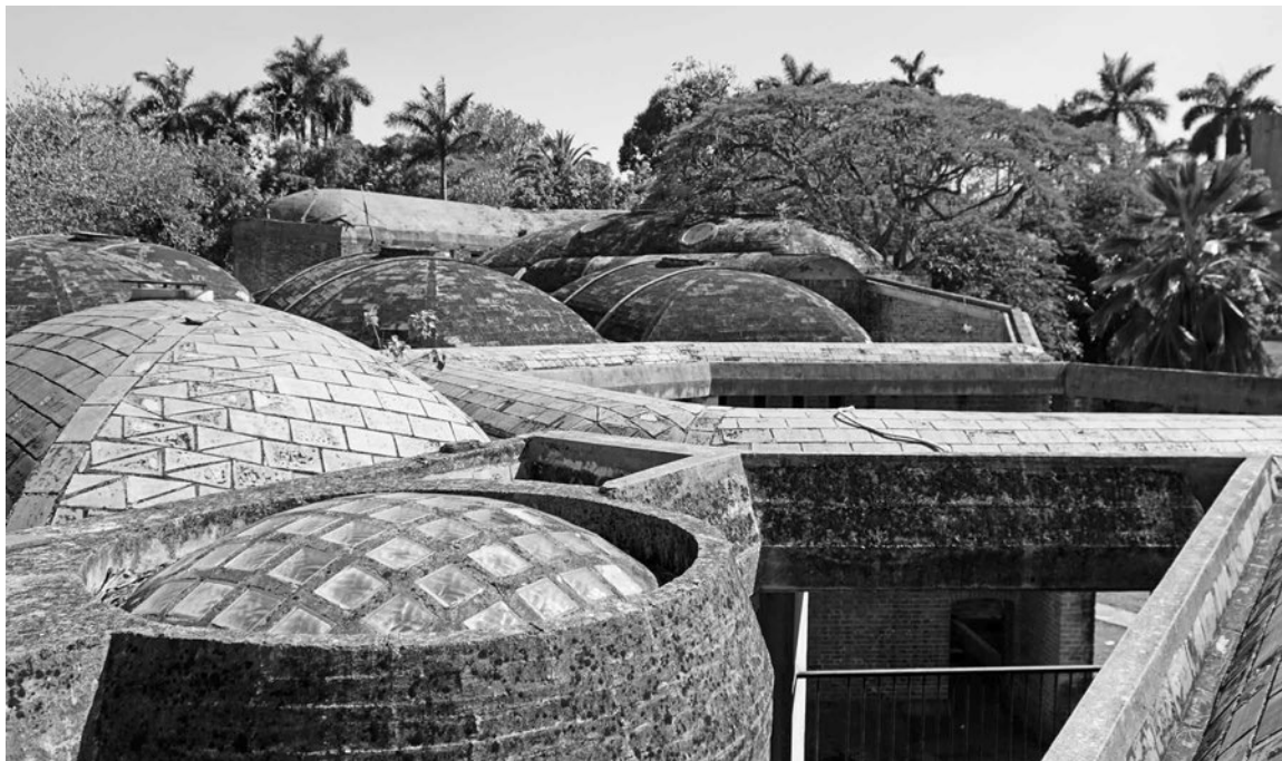
Fig. 1 | Bóvedas que cubren los bloques de la FAT (créditos: Alessandro Merlo). | Volte di copertura dei blocchi della FAT (credits: Alessandro Merlo).
