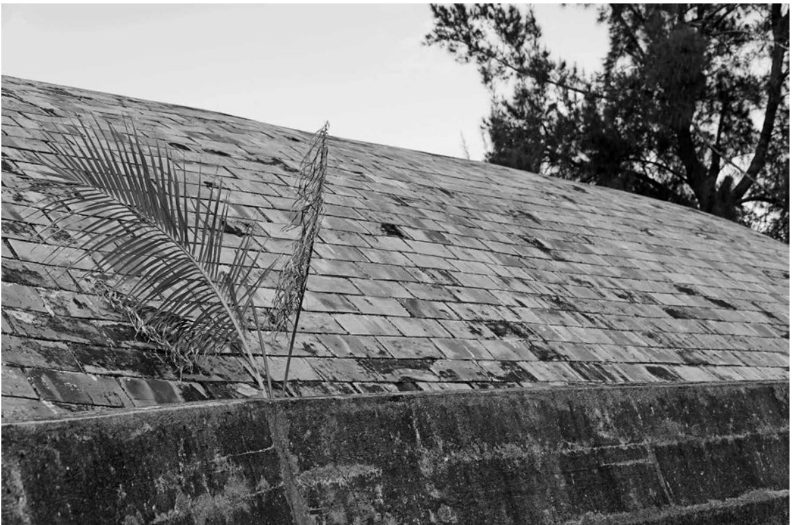
Fig. 19 | Presencia de vegetación vascular de malezas superiores (créditos: Michele Paradiso). | Presenza di vegetazione vascolare superiore infestante (credits: Michele Paradiso).
