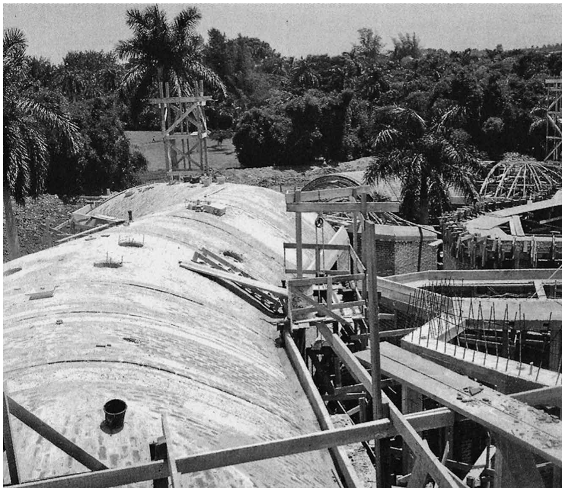
Fig. 16 | Vista de las cúpulas de la Escuela de Teatro en construcción (cortesía de Roberto Gottardi). | Vista delle cupole della Scuola di Teatro in costruzione (cortesía di Roberto Gottardi).
