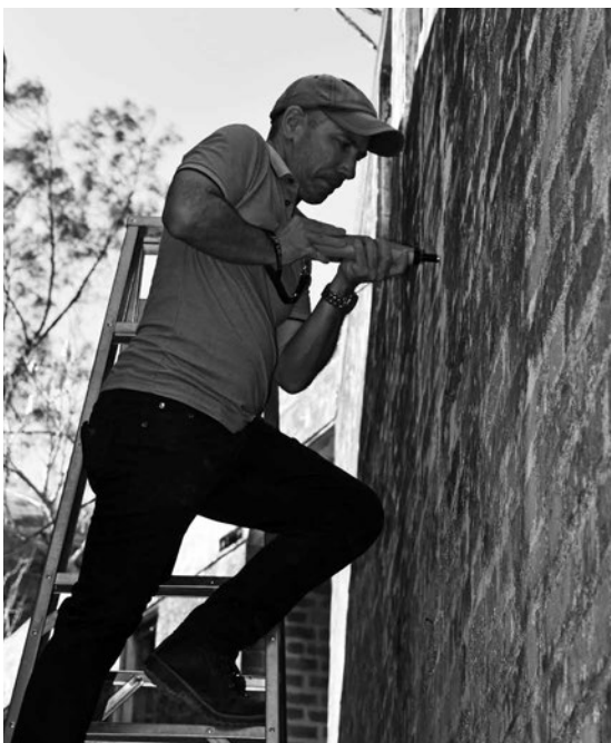
Fig. 24 | Ensayos en estructuras verticales (créditos: Sara Garuglieri). | Saggi nelle strutture verticali (credits: Sara Garuglieri).
