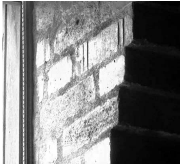
Fig. 13 | Izquierda: Escuela de Ballet, foto de la parte inferior de una rasilla con el nombre de los tejares de origen impreso. Derecha: Escuela de Teatro, detalle de un tabique con el sistema de identificación impreso en los ladrillos (fotografías de Christian Zecchin). | A sinistra: Scuola di Balletto, foto del fondo di una tavola con impresso il nome del tejares di provenienza. A destra: Scuola di Teatro, dettaglio di un setto murario con in evidenza il sistema di riconoscimento impresso sui mattoni (fotografie di Christian Zecchin).
